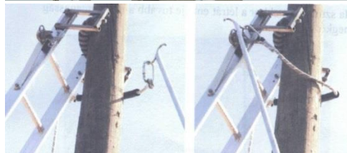
90.-91. Felső rész kötélszerű rögzítése
