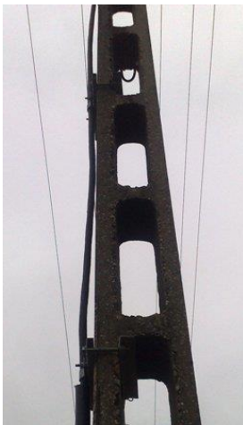
103. Normál áttörésű oszlop (Az áttörés mászható méretű!)
