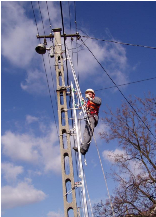
72. Záró elem felszerelése
