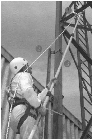
21. Vezető kötélnél felrakása felrakó rúddal
