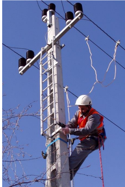
106. Munkaállás felszerelése az áttörésben állva
