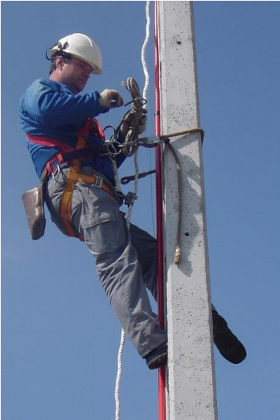
105. Az áttörésben állva a munkaállás felhúzható a kiszolgáló kötéllel
