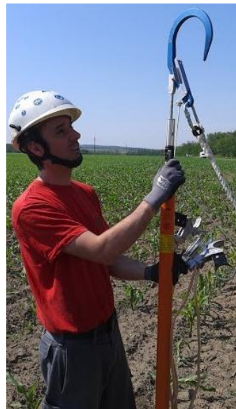
22.-23. Vezető kötélnél zuhanás-gátlóval, kezelőrúddal
