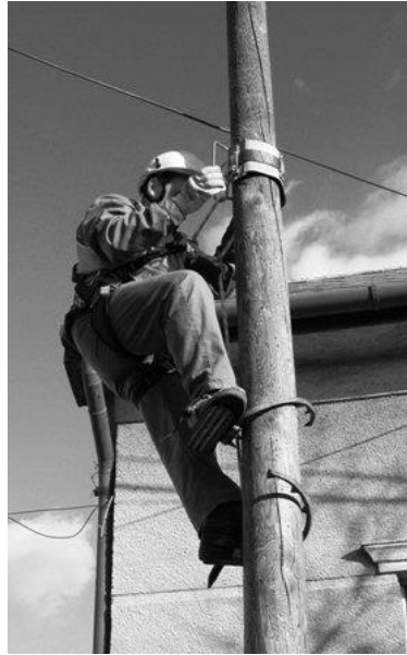
100. Mászás mászó szerszámmal, gyűrűs biztosítással
